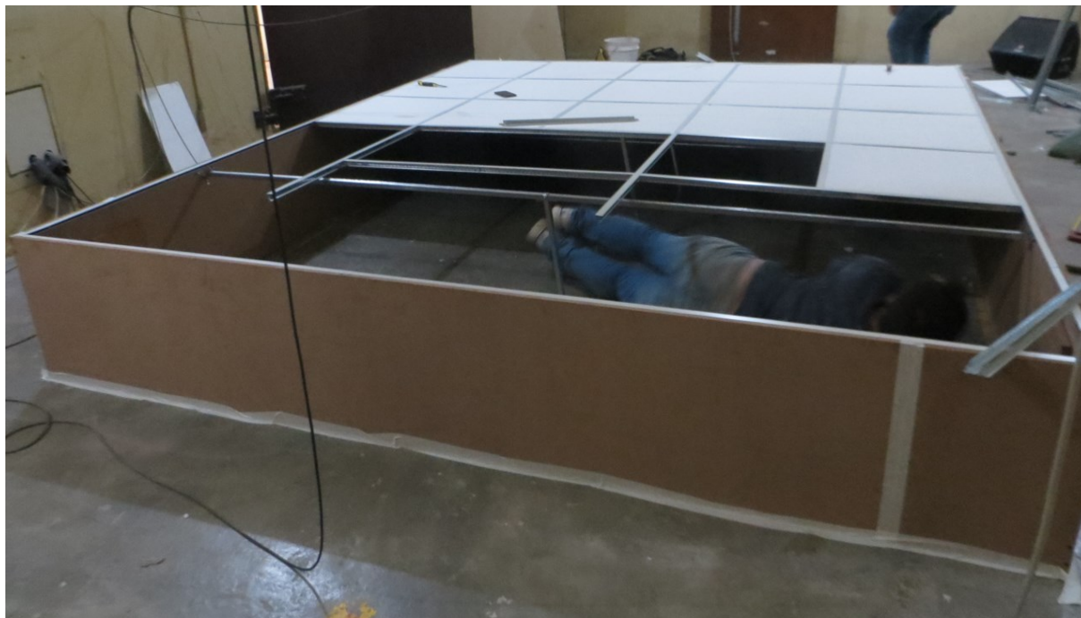
Figura 2.5 – Colocação das placas.
